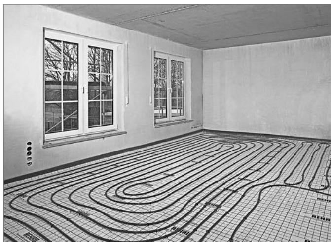
Рис. 21-33 Система крепления труб с помощью гарпун-скоб
