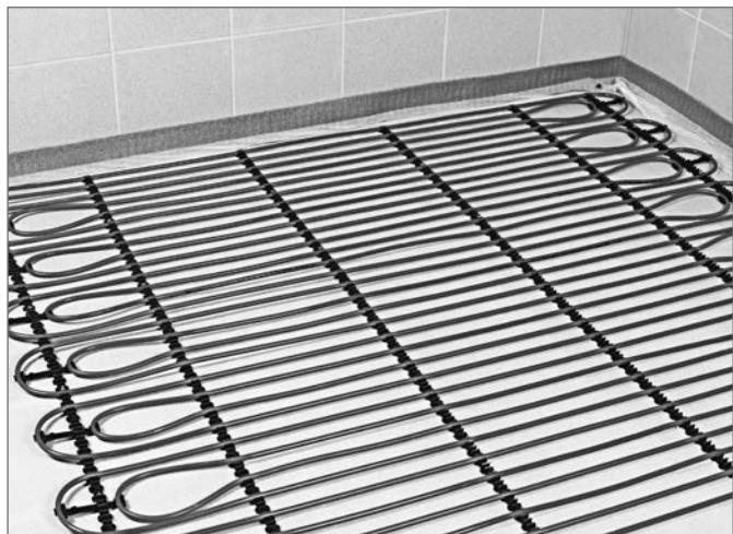
Рис. 21-67 Напольная фиксирующая шина для «мокрого» способа монтажа
