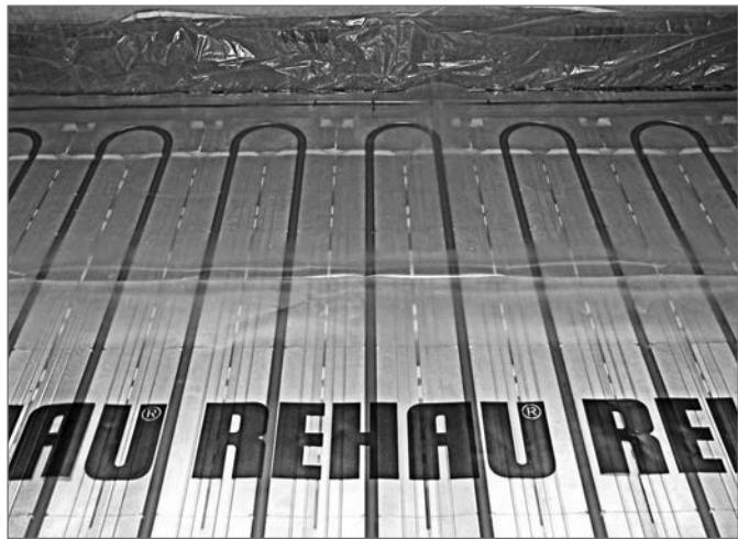
Рис. 22-1 Система укладки труб на теплоизоляционных матах TS-14
