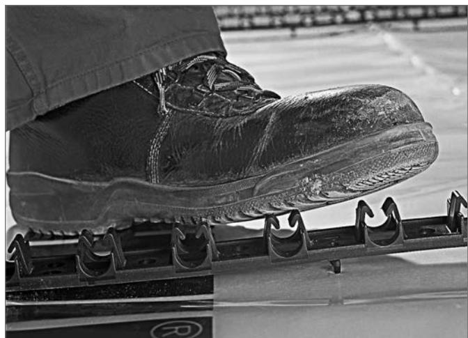
Рис. 21-46 Вдавливание фиксирующих шин RAUFIX в конструкцию пола
