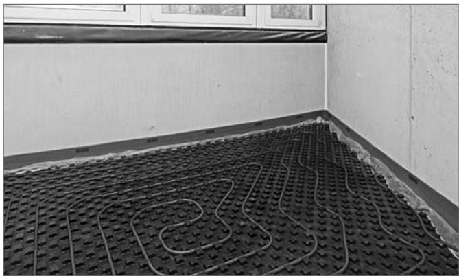
Рис. 21-22 Маты с фиксаторами Varionova с шагозвукоизоляцией 30-2 снизу
