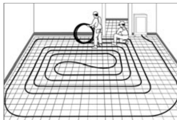
Рис. 143. Обратную часть трубы укладывать «с поворотом» между витками поддающей части трубы.
