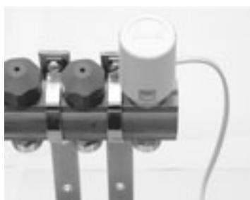
Рис. 154а. Электрический сервомотор установлен на запорном вентиле, вмонтированном на подающем коллекторе распределителя.
