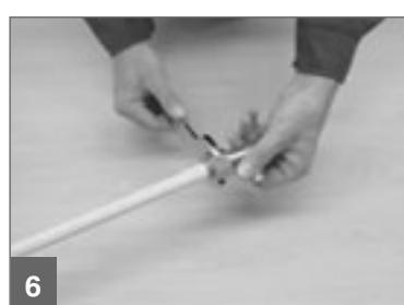
1. Отрезать нужный фрагмент трубы, перпендикулярно ее оси, с помощью специальных ножниц.
