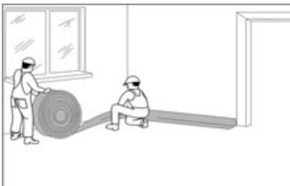
Рис.140. Разложить под стеной изоляционную краевую ленту.
