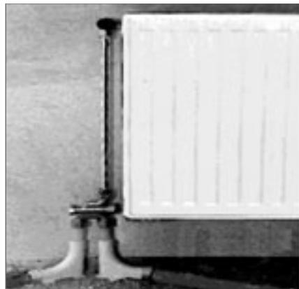
Рис. 13. Отопительный прибор с агрегатным вентилем.
